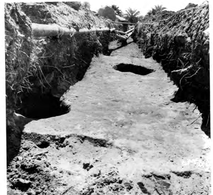
Planche I. Vues transverses de la tranchée montrant l'emplacement des dépôts de fondation. (Cl. Th. Zimmer).
